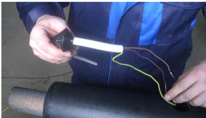
24. Клещами для установки СКВ взять п/э хвостовик сварного кабельного вывода и разместить его, не отпуская, в верхней части насадки на аппарате.
