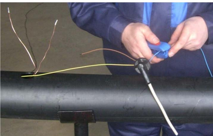
18. Соединить сигнальные проводники, выступающие из отверстия оболочки, с зачищенными проводами СКВ: синий провод соединить с короткой частью сигнального проводника, коричневый с длинной частью (который направлен в сторону заглушки). Провода соединять через обжимные втулки с помощью обжимных клещей.
