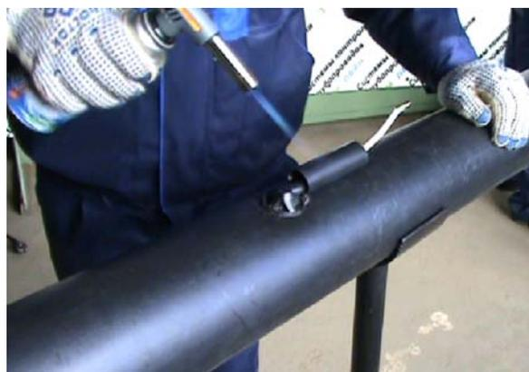
33. Произвести заполнение концевой элемента пенополиуретаном.
