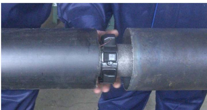
7. Надежно соединить п/э оболочку с последним незакрепленным центратором, таким образом, чтобы центратор находился внутри оболочки на расстоянии 5-10 мм от торца оболочки:
