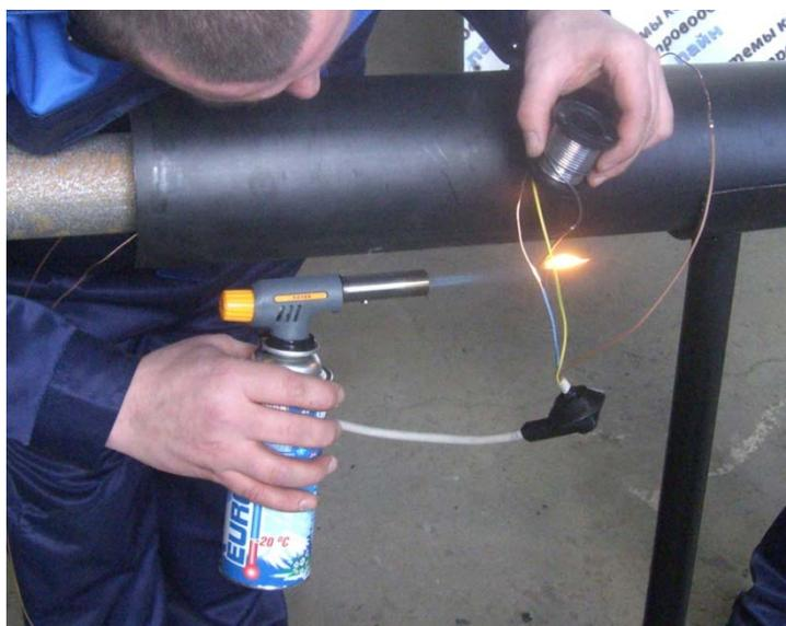
20. Визуально проверить спайку проводов. Физически проверить соединение, потянув за провода в разные стороны.
