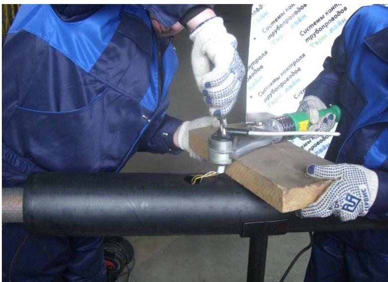
25. Произвести разогрев свариваемой поверхности пробки хвостовика сварного кабельного вывода. Для разогрева всей свариваемой поверхности пробки надо вращать хвостовик в насадке вокруг оси, поворачивая его вправо и влево на 30-40°. Время разогрева 20-30 сек.
