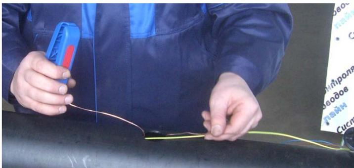
16. К краям разрезанного проводника прикрепить две медные обжимные втулки с помощью обжимных клещей.
