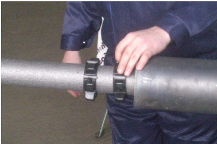
4. Протянуть медную проволоку (длиной 4,2 метра) через отверстия всех (четырех) центраторов со стороны «9 часов», на последнем (четвертом) центраторе проволоку развернуть в обратном направлении (на 180°) и продеть опять через все центраторы (четыре) со стороны «3 часа». На последнем центраторе, который жестко на трубе не закреплен, проволоку продевать через отверстия расположенные в верхней части центратора (ближе к «12 часам»).
